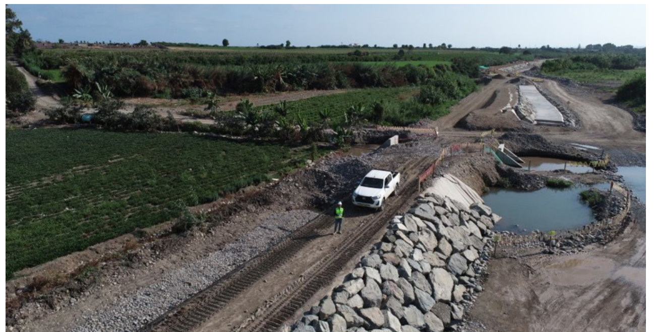
Proyecto protección contra inundaciones del Río Cañete entre el tramo desembocadura del Río Cañete-Localidad de Paullo
