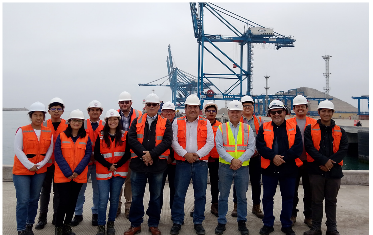
Grúas pórtico de muelle tipo STS, 97 m de altura, brazo de 72 m y de una capacidad superior a 80 ton., al interior las grúas de patio, ambos tipos sobre rieles.
