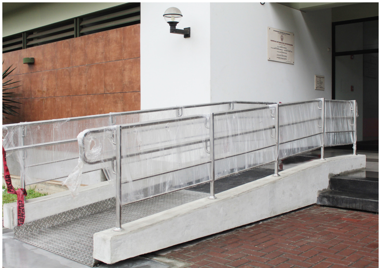
Rampa colocada en edificio UNI
